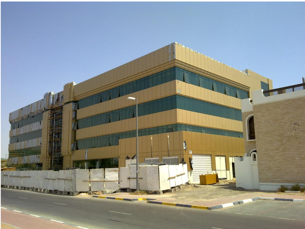
Abb. 3: Bauzustand des Krankenhauses beim Eintreffen in Al Ain.
